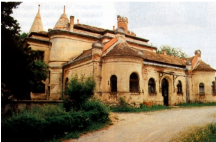
Ulaz u daruvarski dvorac
