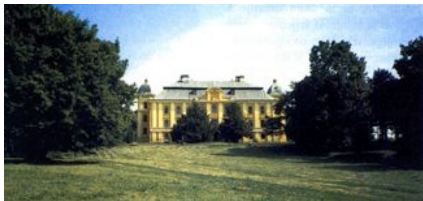
Sjeverno (perivojno) pročelje velikog dvorca
