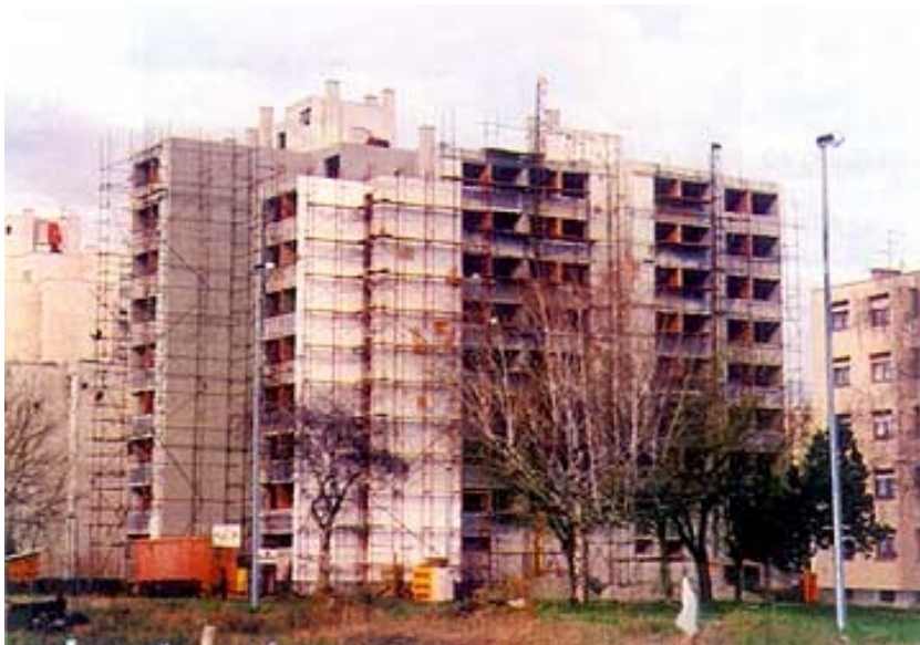
Obnova zgrade BZ-1 u vukovarskom predjelu Borovo
