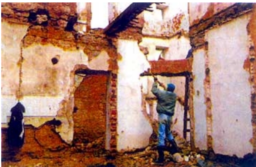
Obnova stambene zgrade u Vojniću
