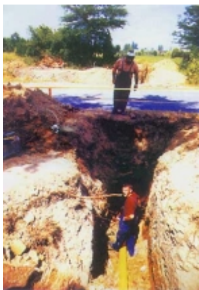
Obnova komunalne infrastrukture u Podunavlju
