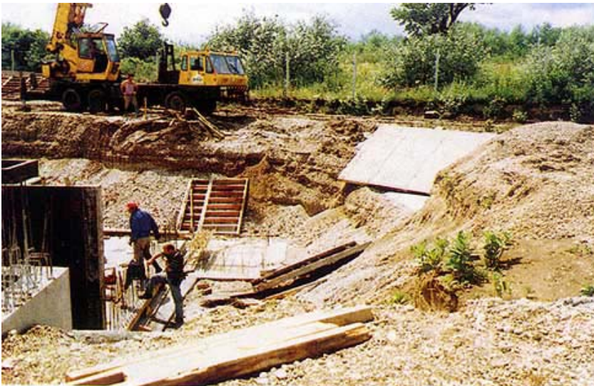
Gradište podvoznjaka u Ljubljanskoj aveniji
