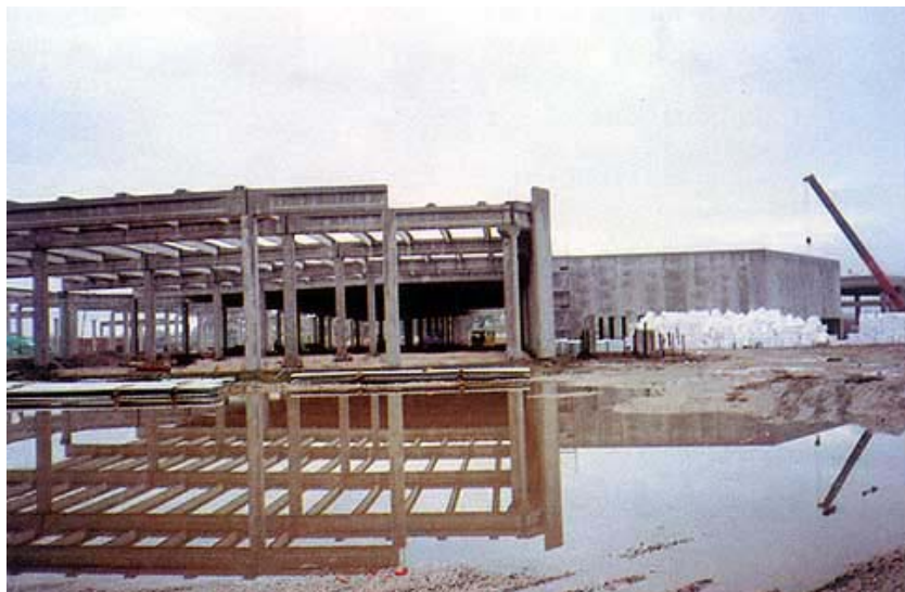
Pogled na gradilište s istoka
