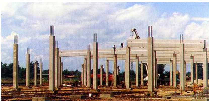
Montaža armiranobetonske konstrukcije
