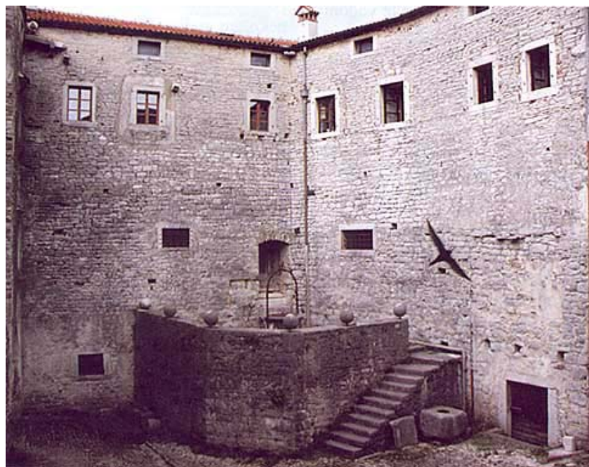
Dio dvorišta s cisternom
