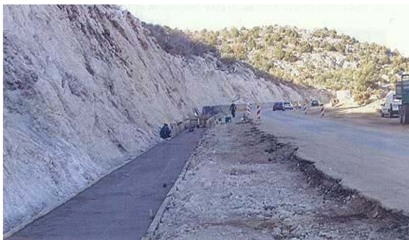
Radovi na traku za spora vozila
