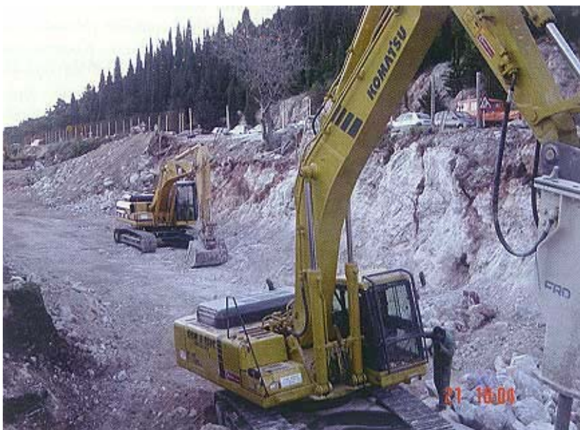
Radovi na rampi
