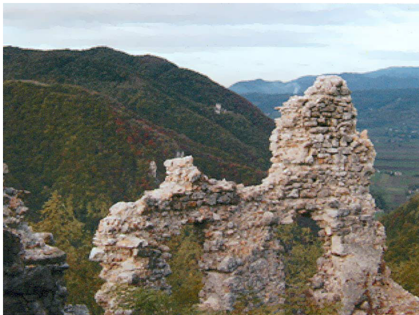
Pogled kroz dijelove zapadnih ruševina središnje jezgre prema Kunšperku
