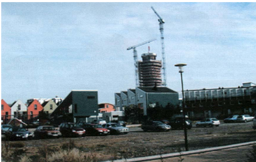
Gradnja tornja uz naselje u Malmöu
