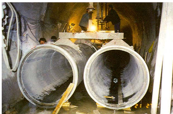
Slika 6. Montaža protivuzgonske konstrukcije
