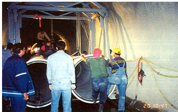
Slika 5. Montaža cijevi u tunelu
