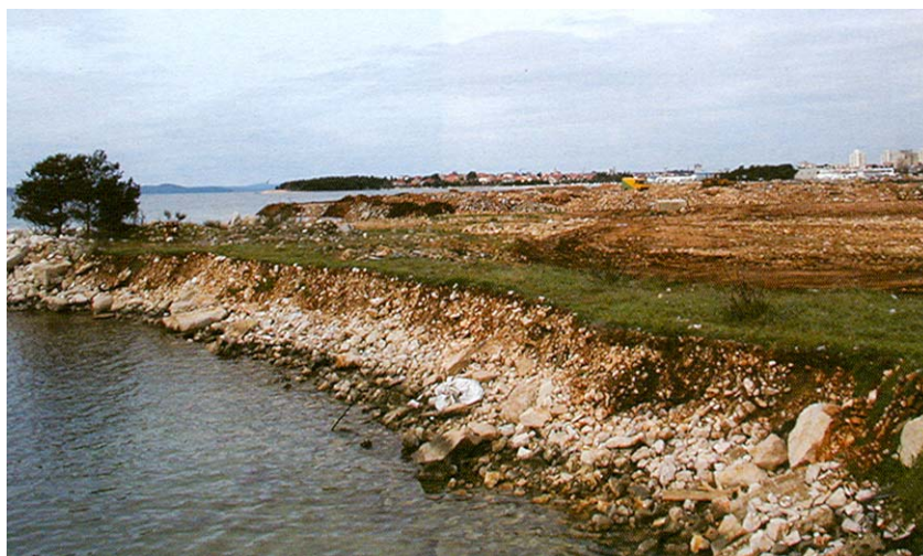
Početak nasipanja za uređenje nove luke u Gaženici
