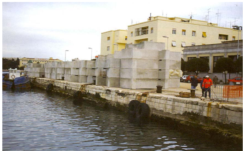
Betonski blokovi na dijelu Istarske obale koji se ne obnavlja pripremljeni za ugradnju
