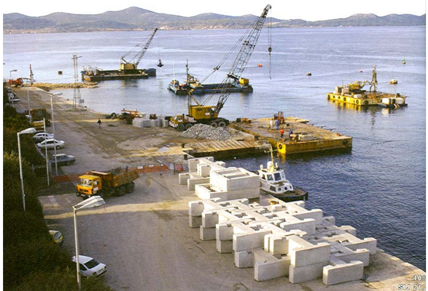
Gradilište nove obale na početku 2004.
