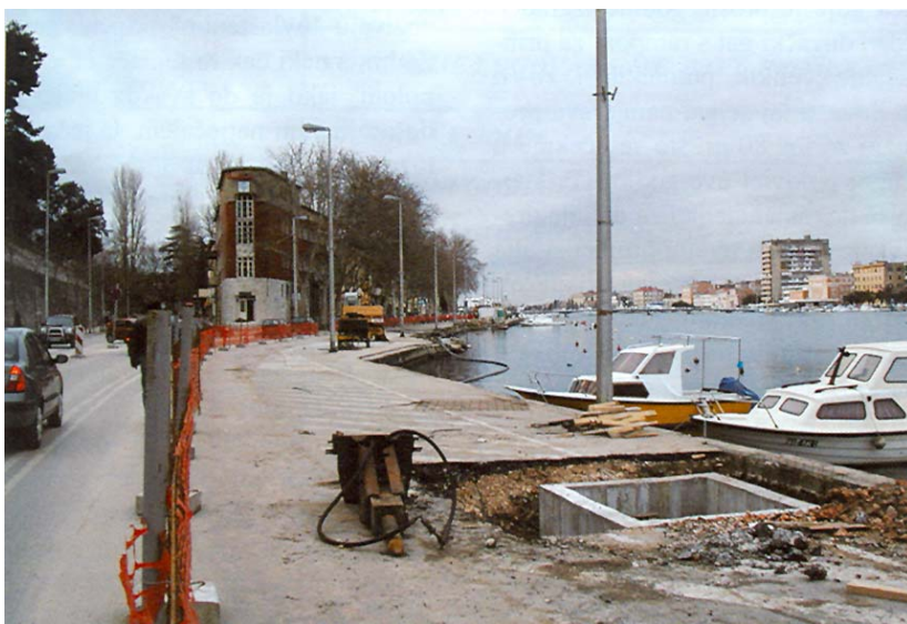
Obnova rive u gradskoj luci
