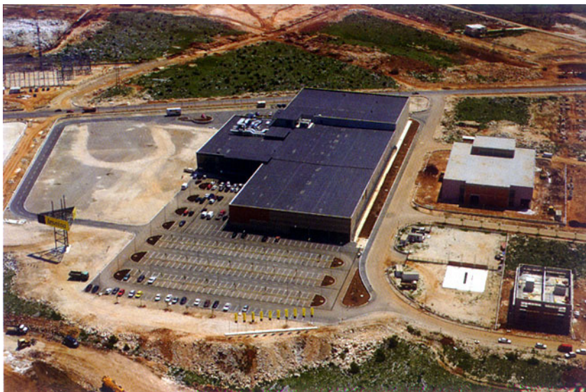
Zgrada i prostor Lesnine, najveći u poduzetničkoj zoni
