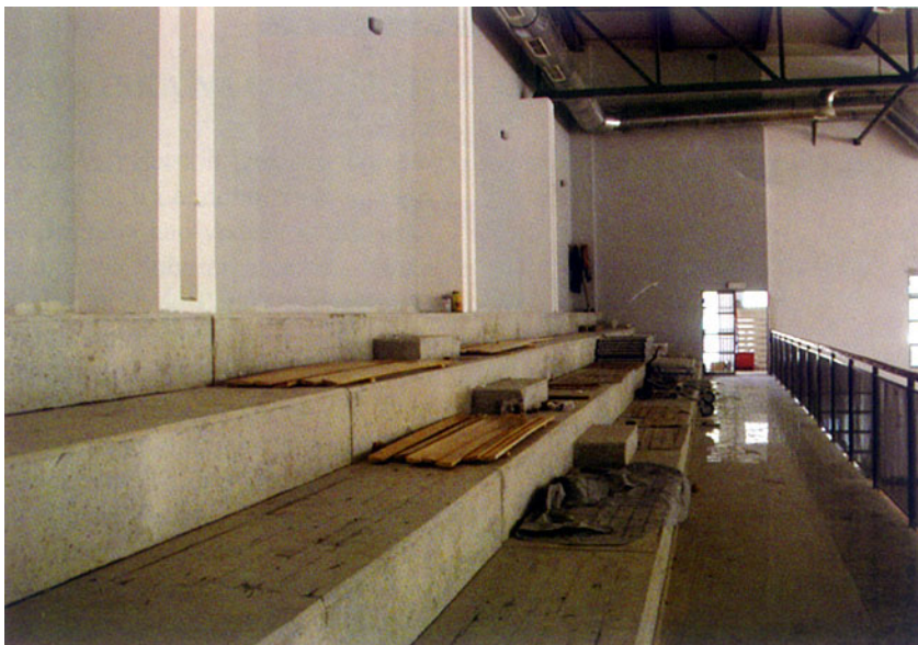
Radovi na gledalištu u velikoj dvorani
