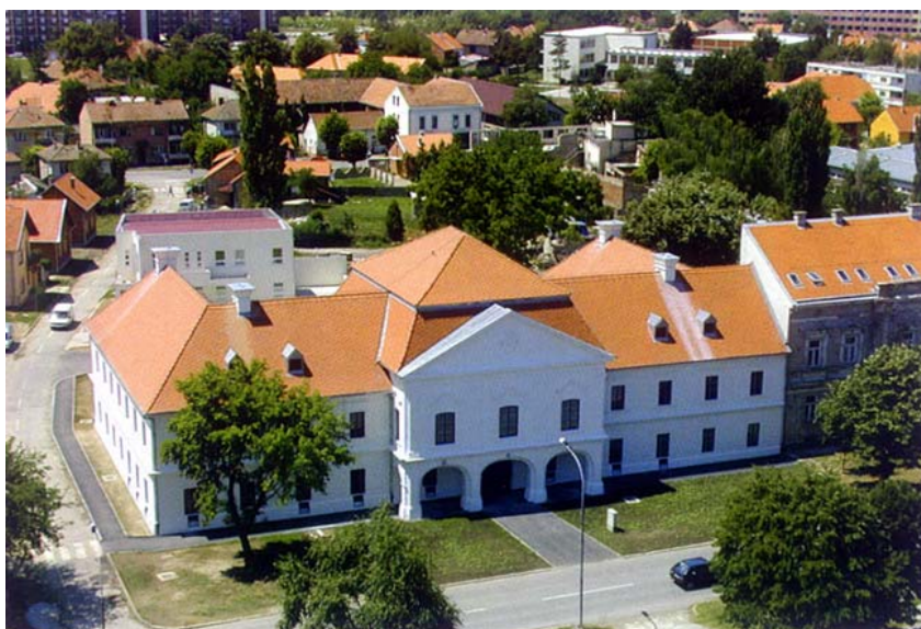
Obnovljena zgrada Županije srijemske
