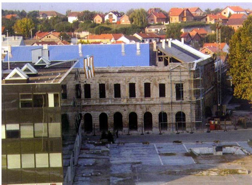
Radovi na krovu zgrade Radničkog doma
