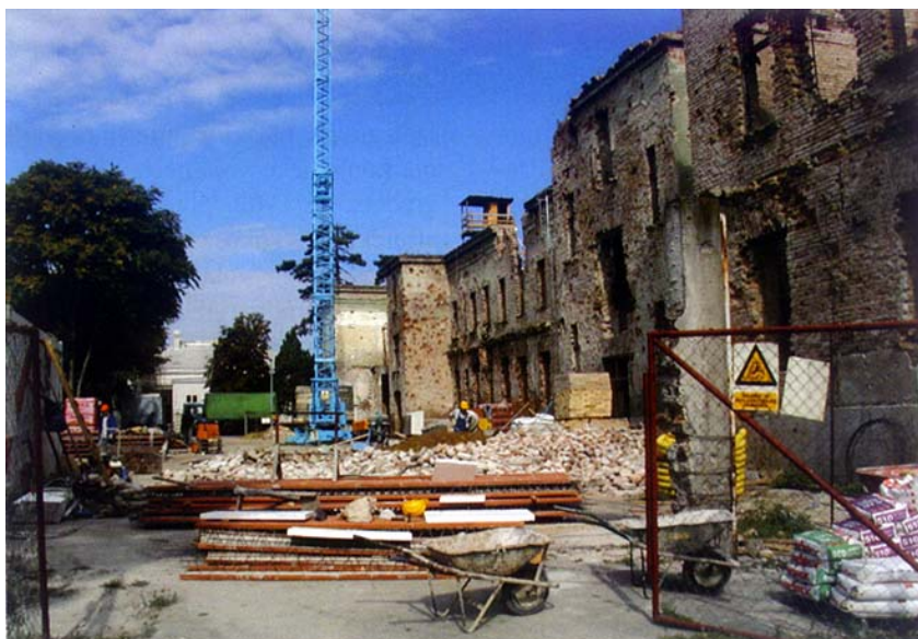
Gradilište obnove Županijskog suda s dvorišne strane
