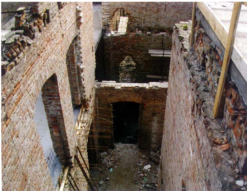
Obnova unutrašnjosti Županijskog suda
