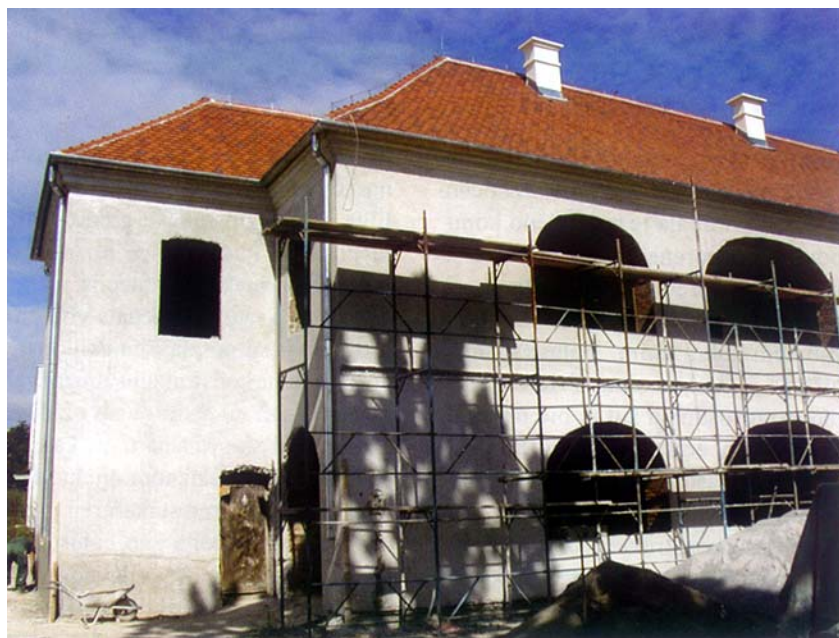
Obnova zgrade Kotarske oblasti
