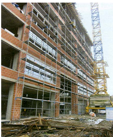
Pogled na zgradu u gradnji
