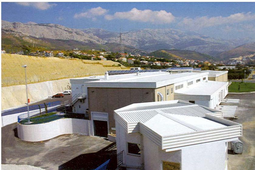
Pogled na zgrade uređaja za pročišćavanje otpadnih voda Stupe
