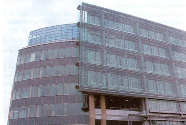
Slika 2. Pogled sa sjeverozapada
