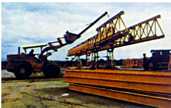
Slika 11. Montaža postrojenja za navlačenje
