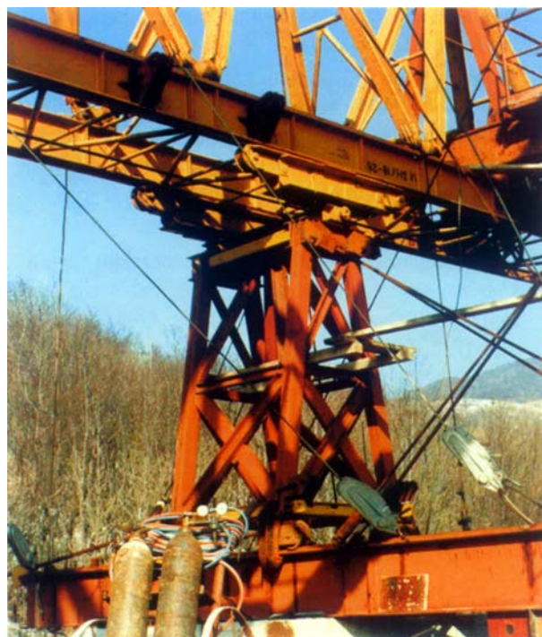
Slika 8. Rešetkasti stupovi na kotačima (most Hreljin)
