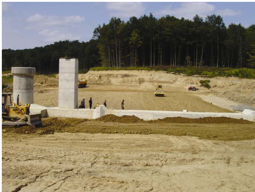
Početak nasipanja brane
