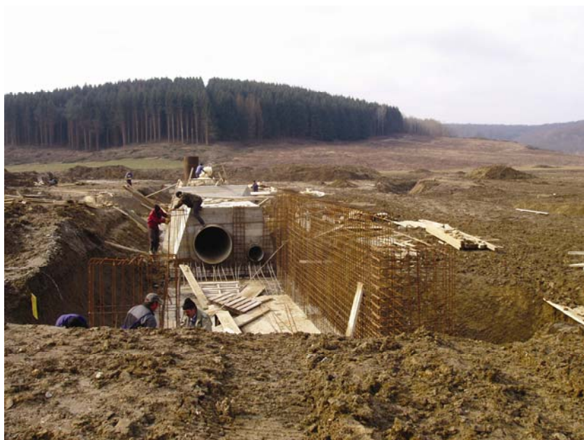
Radovi na temeljnom ispustu
