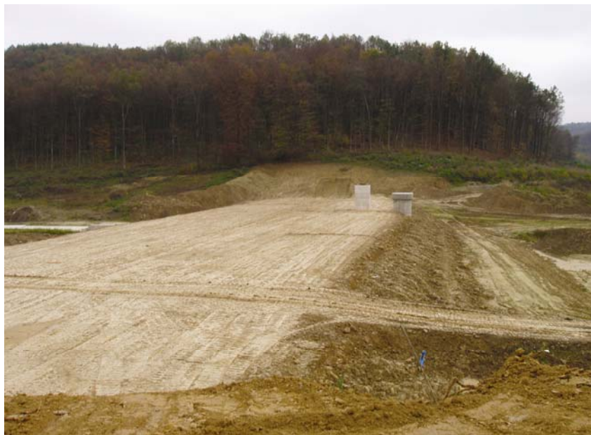
Brana u vrijeme posjeta gradilištu
