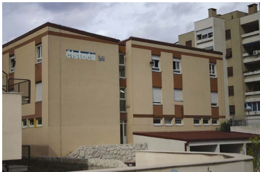
Upravna zgrada splitske Čistoće
