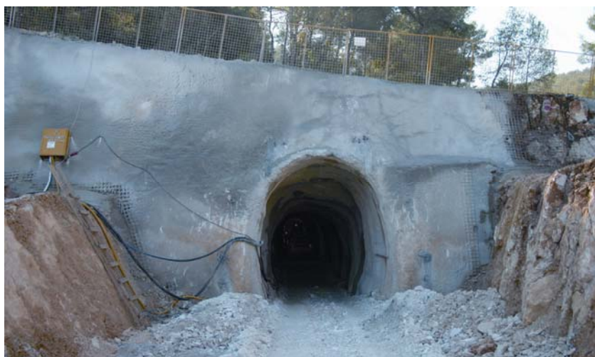
Sjeverni portal tunela Čiovo
