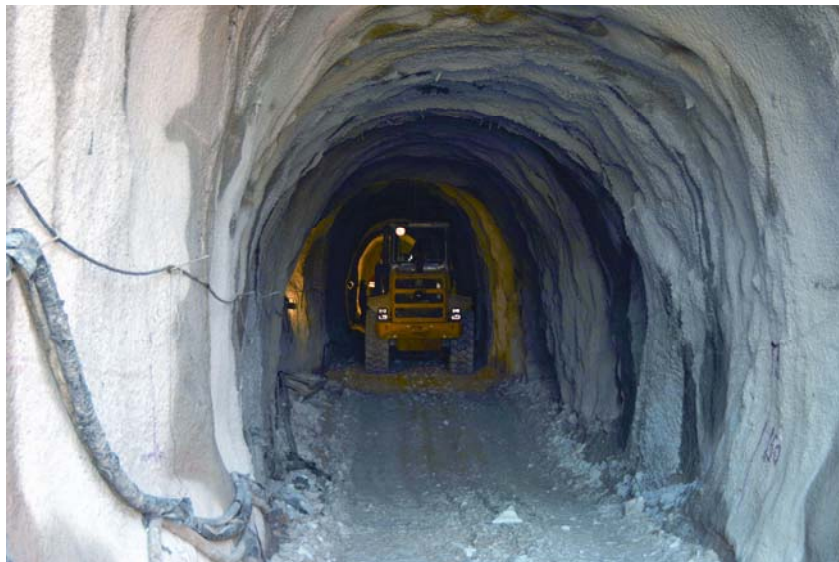
Radovi u tunelu
