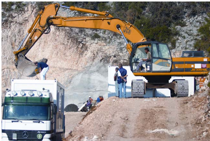
Radovi na prilazima tunelu Čiovo
