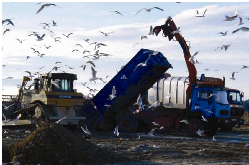
Dovoženje otpada na odlagalište Karepovac
