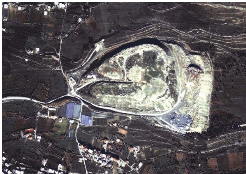
Pogled iz zraka na splitsko odlagalište Karepovac
