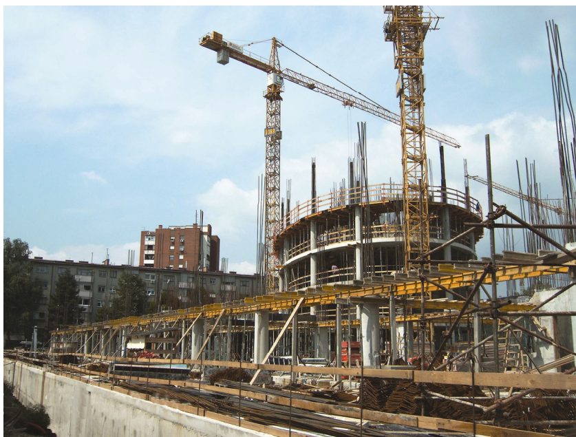
Gradilište u prvim fazama gradnje
