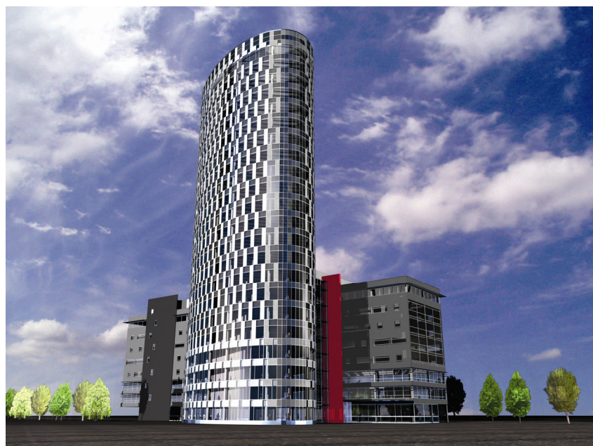
Prikaz novoga zagrebačkoga eliptičnog tornja
