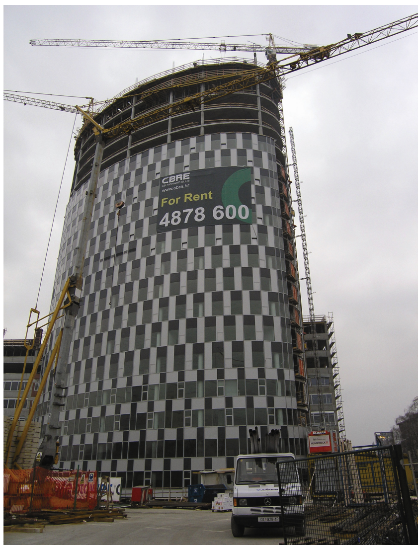
Toranj u gradnji snimljen iz Ulice grada Vukovara
