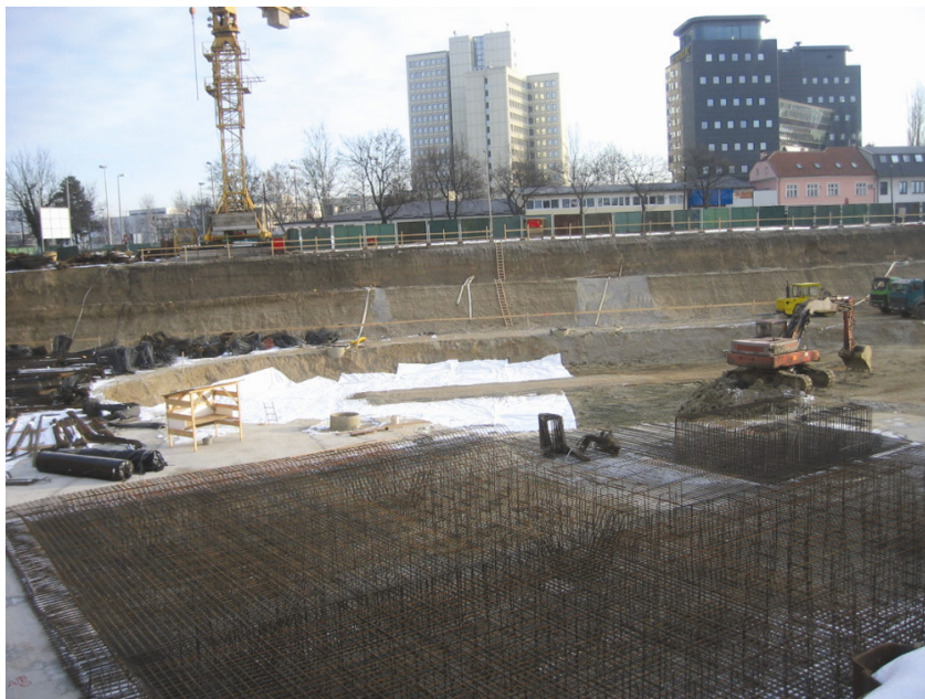
Radovi u građevnoj jami
