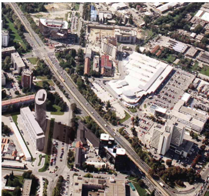
Zgrada Zagrebtowera smještena među okolnim zgradama
