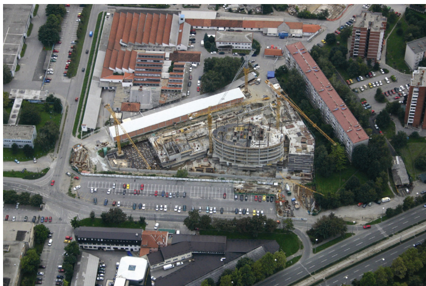
Pogled iz zraka na gradilište
