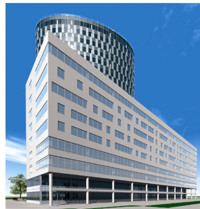
Pročelje uzdužne građevine
