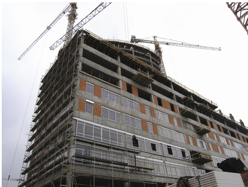
Uzdužna građevina u gradnji
