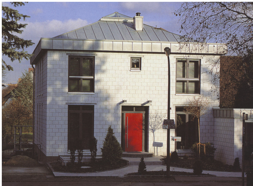
Slika 2. Zgrada s limenim pokrovom
