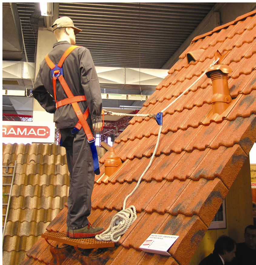
Jedan od propisanih načina zaštite pri radu na krovu
