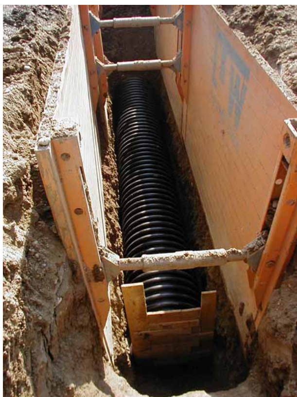
Slika 2. Radovi na polaganju kolektora
