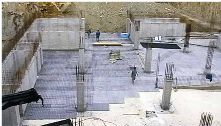
Slika 1. Hidroizolacija temeljne ploče na građevini Lazarica, Split
