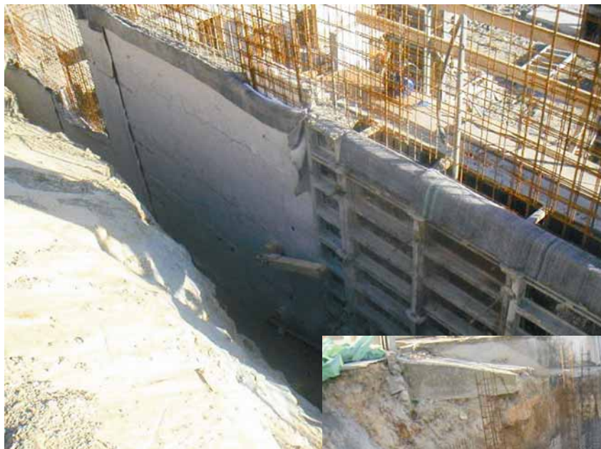
Slika 2. Hidroizolacija podrumskog zida na stambenoj građevini u Splitu
