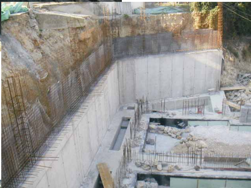
Slika 3. Hidroizolacija podrumskog zida izravno uz iskop na poslovnoj građevini u Splitu
