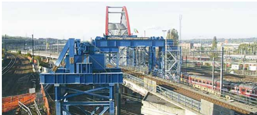
Gradilište u fazi navlačenja konstrukcije
