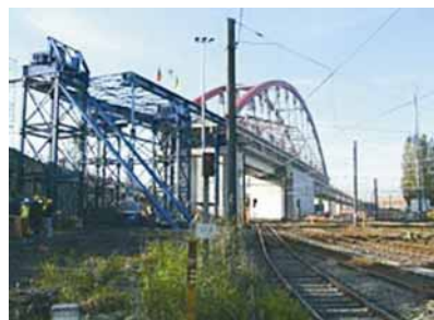
Željeznički most dužine 140 m i težine 1600 t potpuno pod kontrolom
