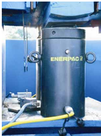
Cilindri ispod natezne grede održavaju most na točno određenoj visini
