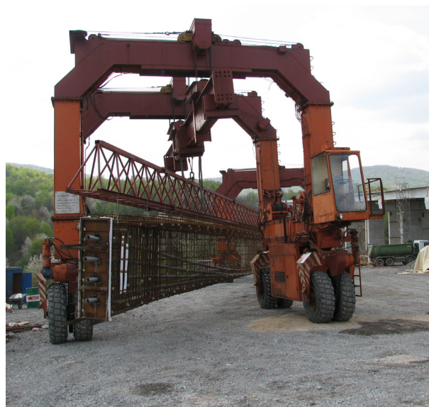
Slika 8. Gradis-HENG Apola tijekom nošenja armaturnog koša
