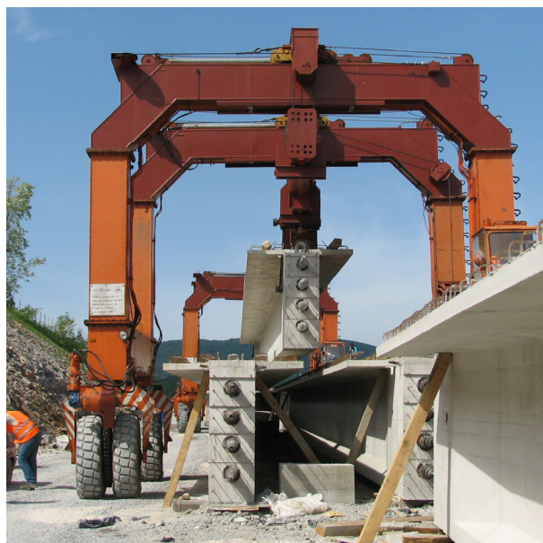
Slika 6. Modificirani Gradis-HENG Apola pri uporabi na vijaduktu Severinske drage
