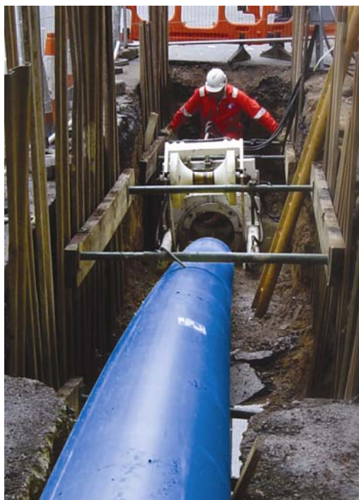
Postavljanje cijevi Rolldown/Swage-Lining postupkom
