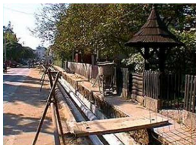
Radovi na obnovi cjevovoda
