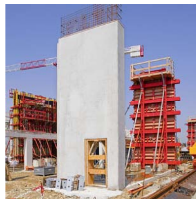
Izvedba stupova visine 12 m
