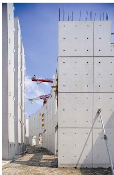
Pročeljni zidovi od vidljivoga betona
