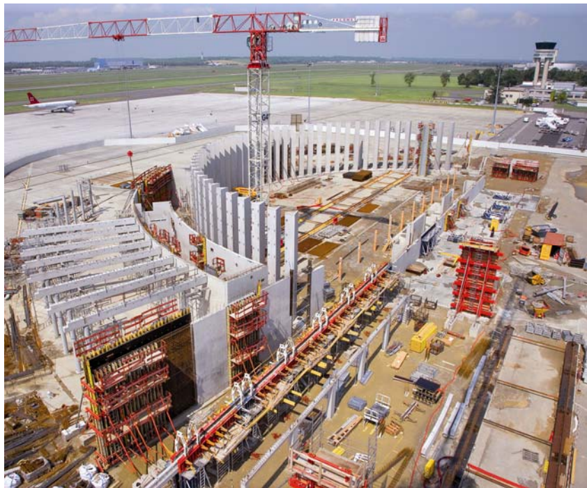
Izvođenje zgrade D zračne luke Toulouse-Blagnac
