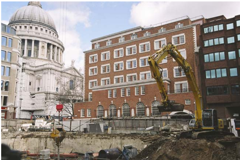
Pogled na gradilište s katedralom u pozadini
