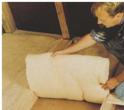
Polaganje izolacije od ovčje vune
