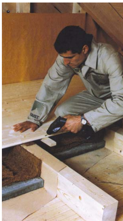
Ploče od kokosova vlakna kao podna izolacija
