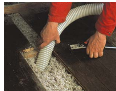
Ugrađivanje celulozne izolacije (pahuljice) upuhivanjem
