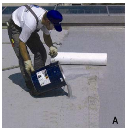
Izvedba izolacije Kemperolom : A – nanošenje materijala na podlogu, B - polaganje filca tako da ne nastanu mjehurići, C - obrada
