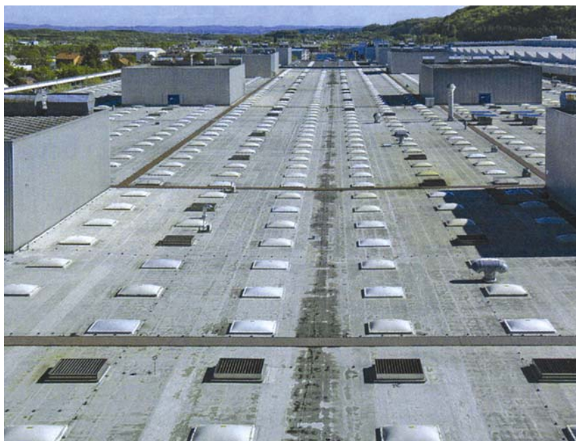
Dio ravnog krova na građevini BMW Steyr zabrtvljen Kemperolom
