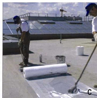
Izvedba izolacije Kemperolom : A – nanošenje materijala na podlogu, B - polaganje filca tako da ne nastanu mjehurići, C - obrada
