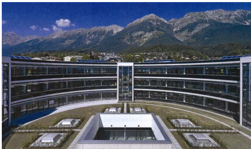
Poslovna zgrada Kemperola , kompletno zabrtvljena vlastitim materijalima
