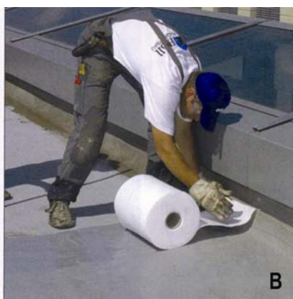
Izvedba izolacije Kemperolom : A – nanošenje materijala na podlogu, B - polaganje filca tako da ne nastanu mjehurići, C - obrada
