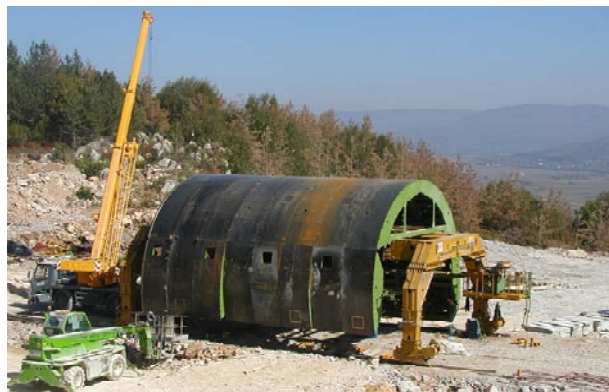
Slika 2. Dvotračna tunelska oplata CIFA u završnoj fazi montaže na gradilištu tunela Sv. Rok
