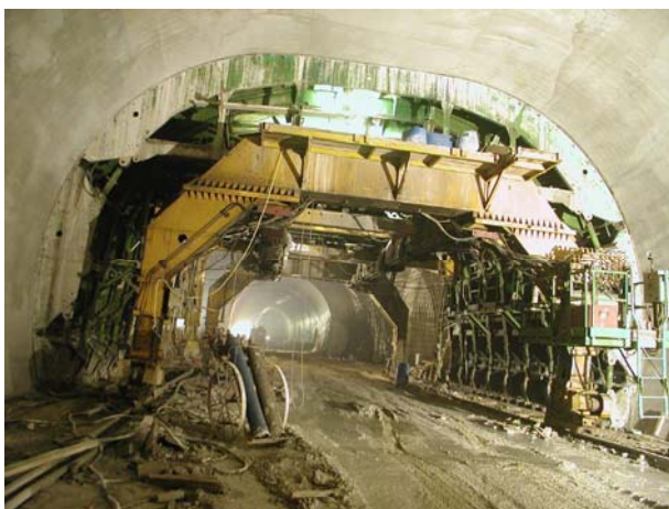
Slika 4. Faza očvršćivanja neposredno prije odvajanja plašta oplate u proširenju tunela Sveti Rok
