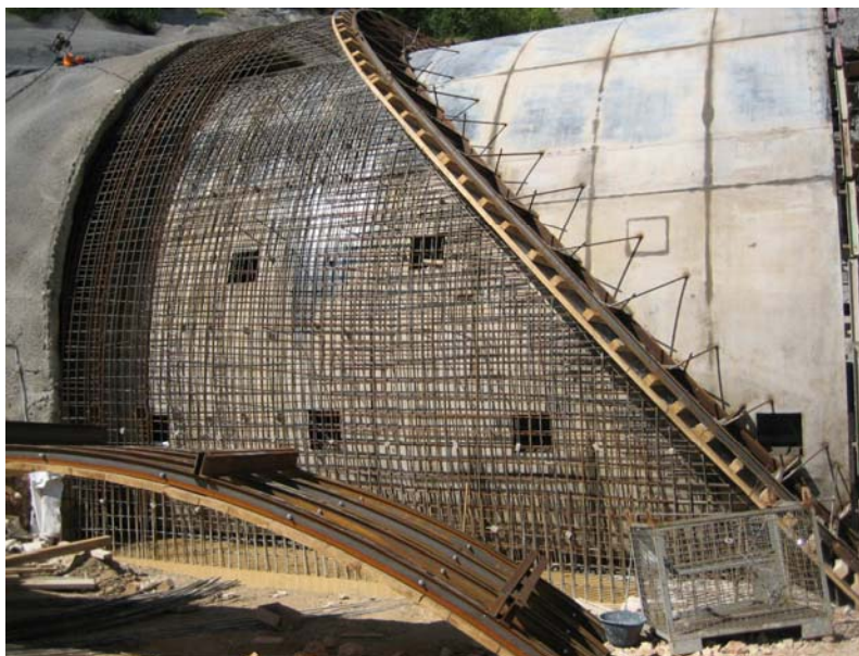
Slika 7. Kosa čelna i portalna oplata
