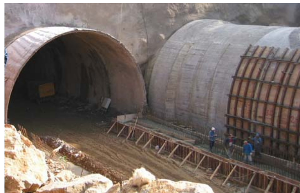
Slika 3. Betoniranje portala desne cijevi i izvlačenje pasice lijeve cijevi u tunelu Jušići
