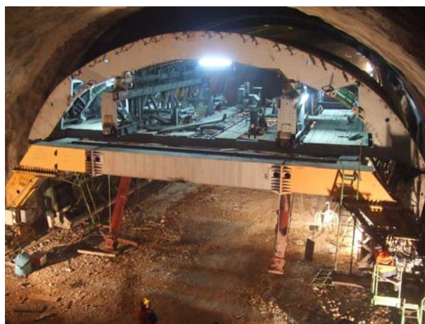
Slika 10. Posljednja faza montaže četvertračne tunelske oplata u tunelu Pećine
