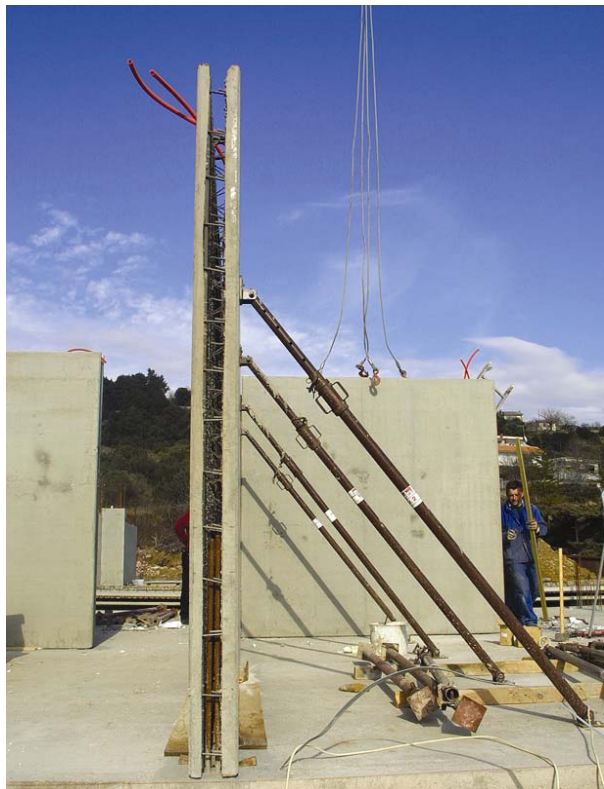
Pogled na armaturne koševе između dvije stjenke armiranog betona
