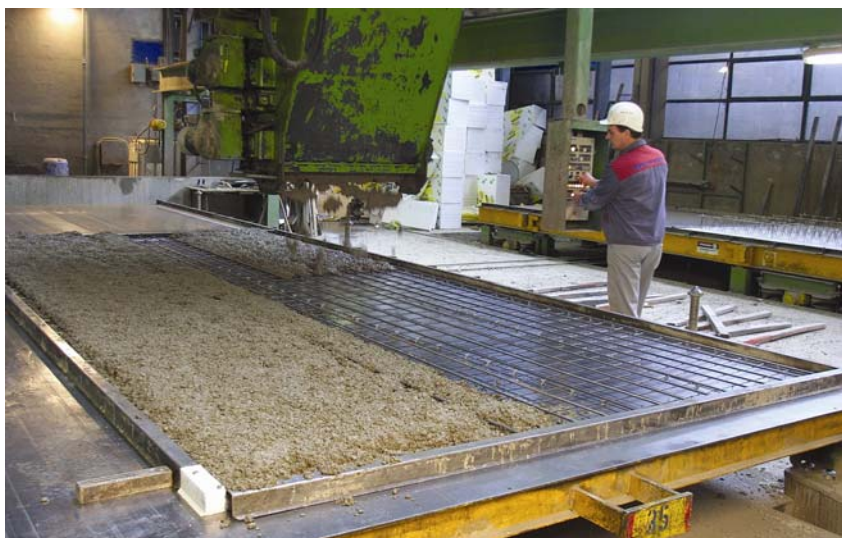
Betoniranje zida na oplatom stolu
