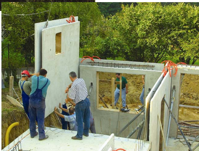
Montaža zidova na gradilištu
