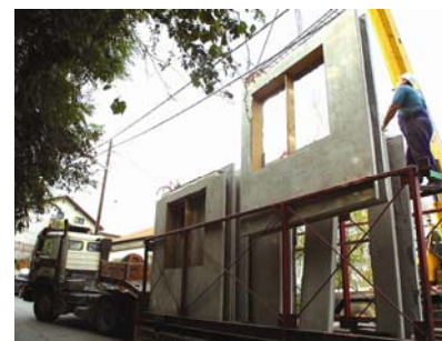
Prijevoz zidova iz pogona do gradilišta
