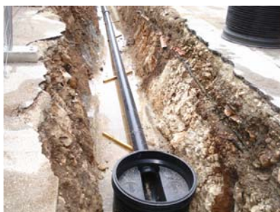
Gradnja kanalizacijskog sustava u Rogoznici
