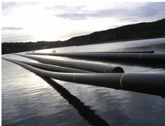
Polaganje cijevi podmorskog ispusta u Biogradu
