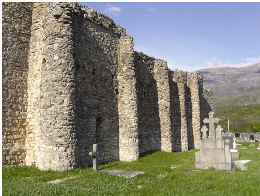
Obli kontrafori crkve Sv. Spasa
