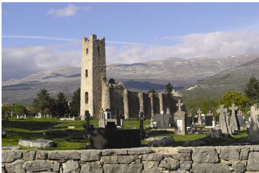
Pogled na crkvu Sv. Spasa s grobljanske ograde
