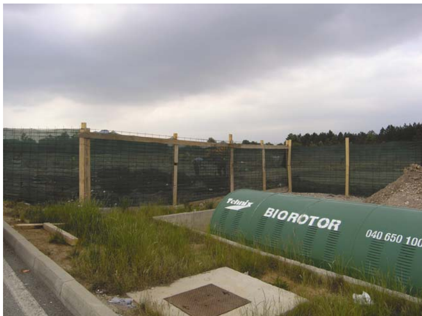
Izgradnja biološkog diska na PUO Zir
