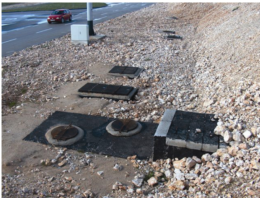
Separator otpadnih voda uz autocestu pokraj Benkovca
