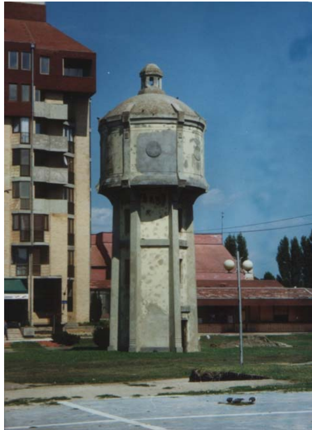
Slika 6. Današnje stanje vodotornja, fot. D. Damjanovića
