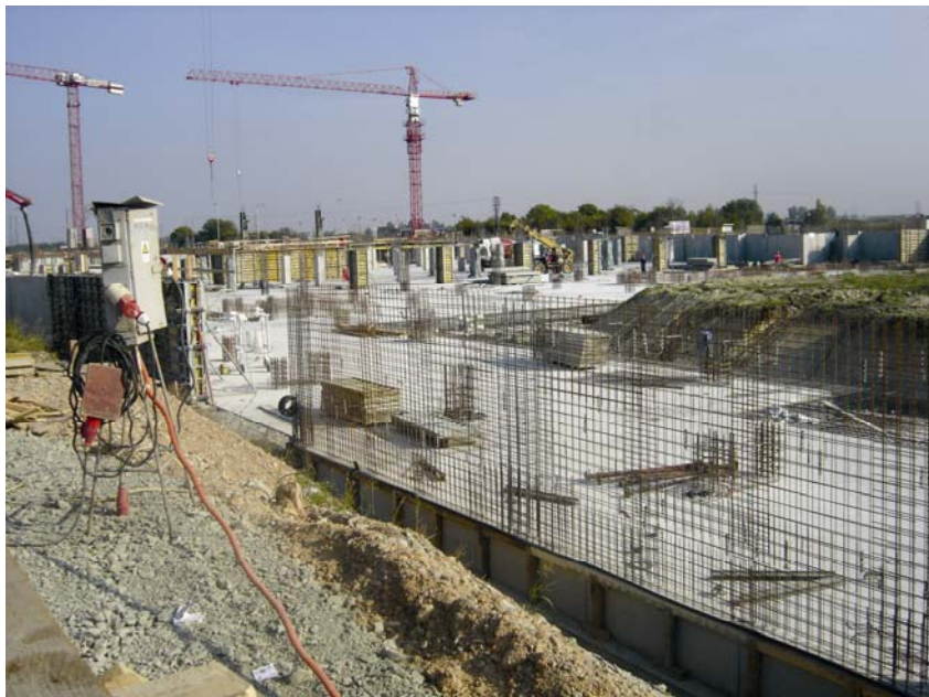
Armiranobetonski radovi u podrumu građevine
