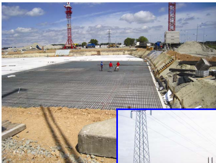
Izvedba poda podzemne garaže
