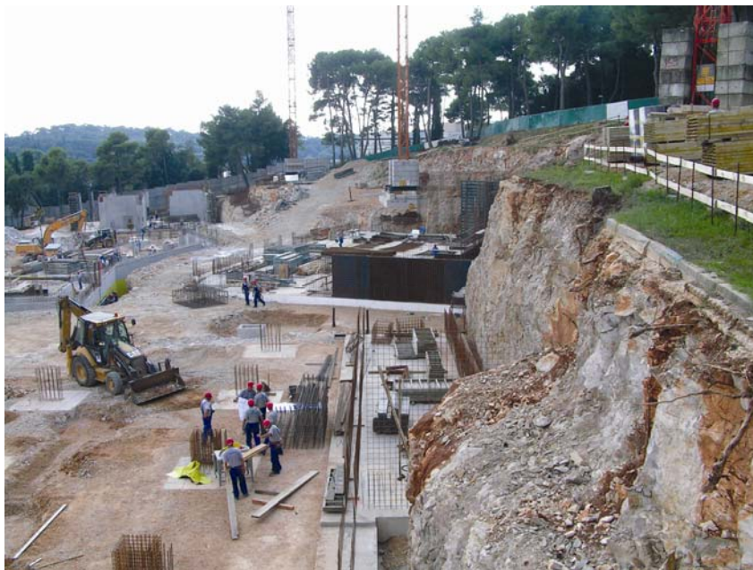
Betoniranje temelja i pripreme za nastavak izgradnje
