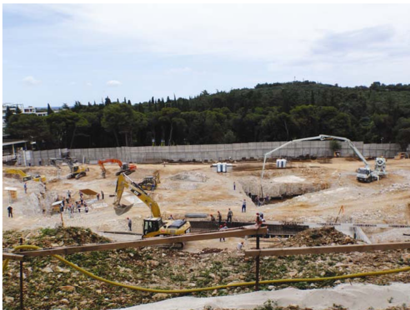
Završni radovi iskopa u građevinskoj jami
