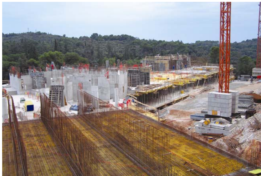
Početak izgradnje prve nadzemne etaže
