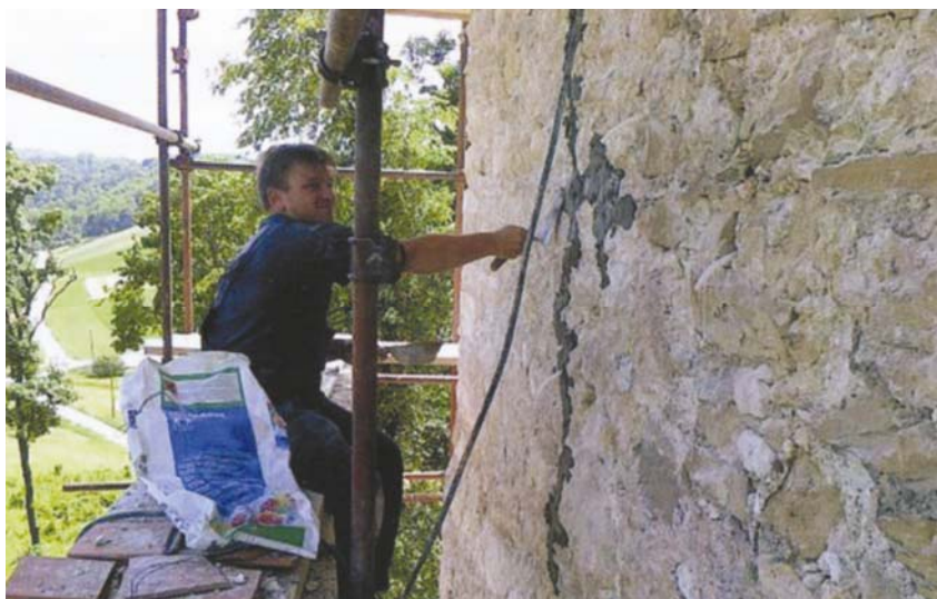
Zatvaranje sljubnica reparaturnim mortom
