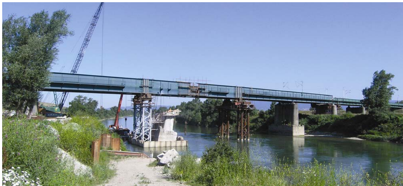
Izravnani željeznički most Jakuševac
