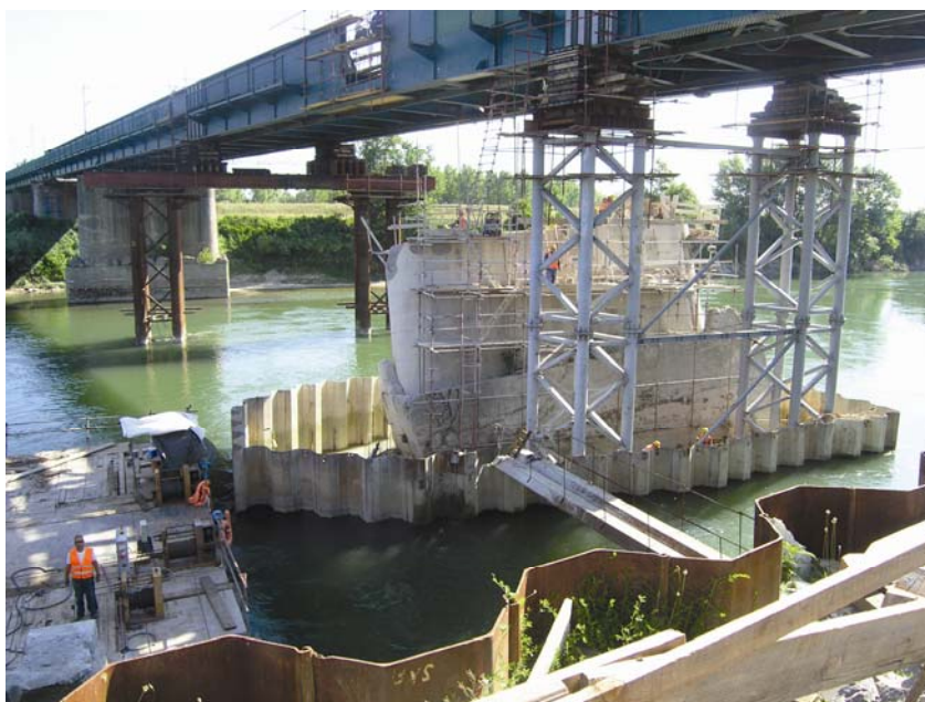
Radovi sanacije temelja i rušenja stupa S6
