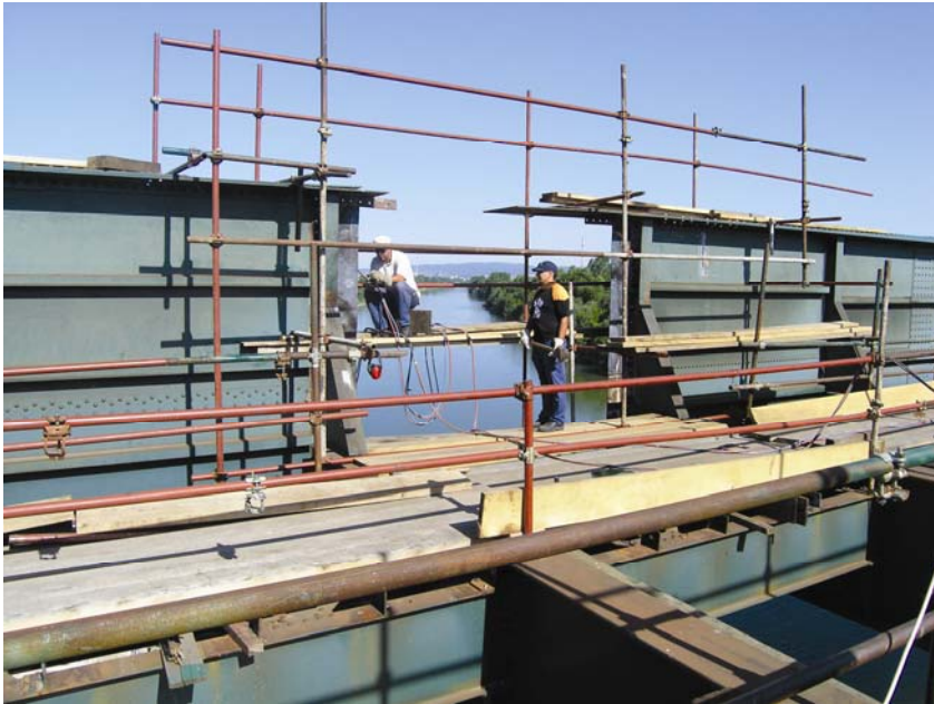
Sanacija čelične konstrukcije iznad stupa S6
