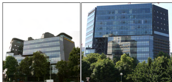
Slika 1. Izgled građevine: a) prije nadogradnje, b) danas
