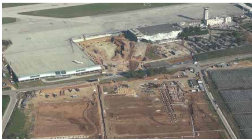
Pogled na zračnu luku tijekom izvođenja zemljanih radova
