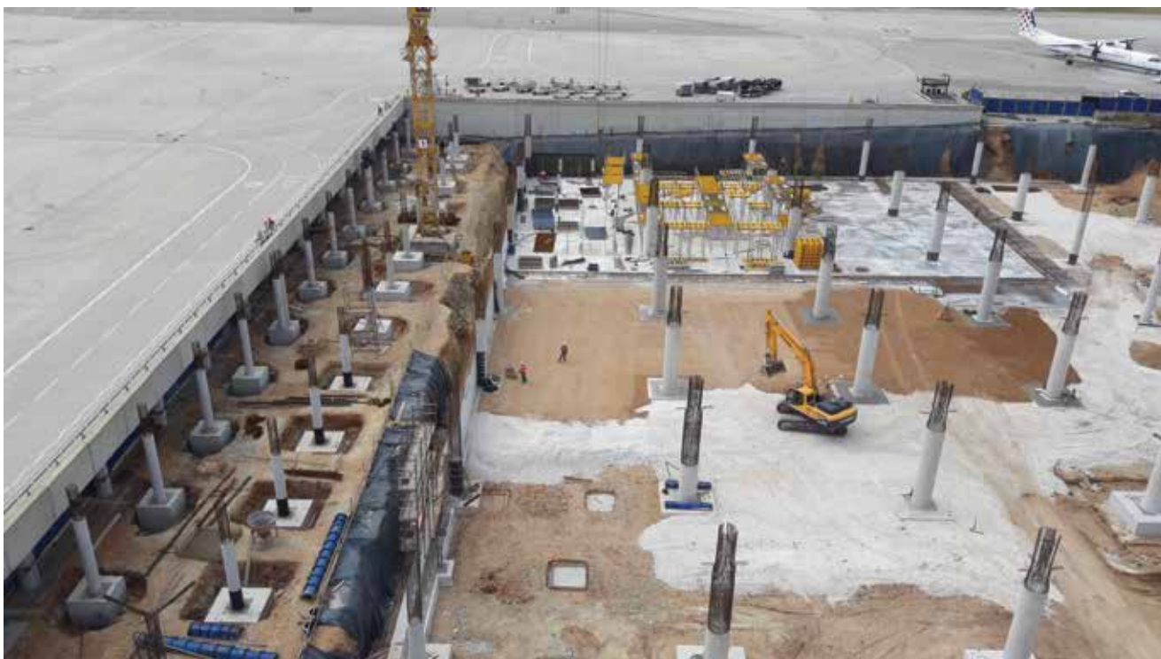
Temeljenje stupova podruma nove putničke zgrade
