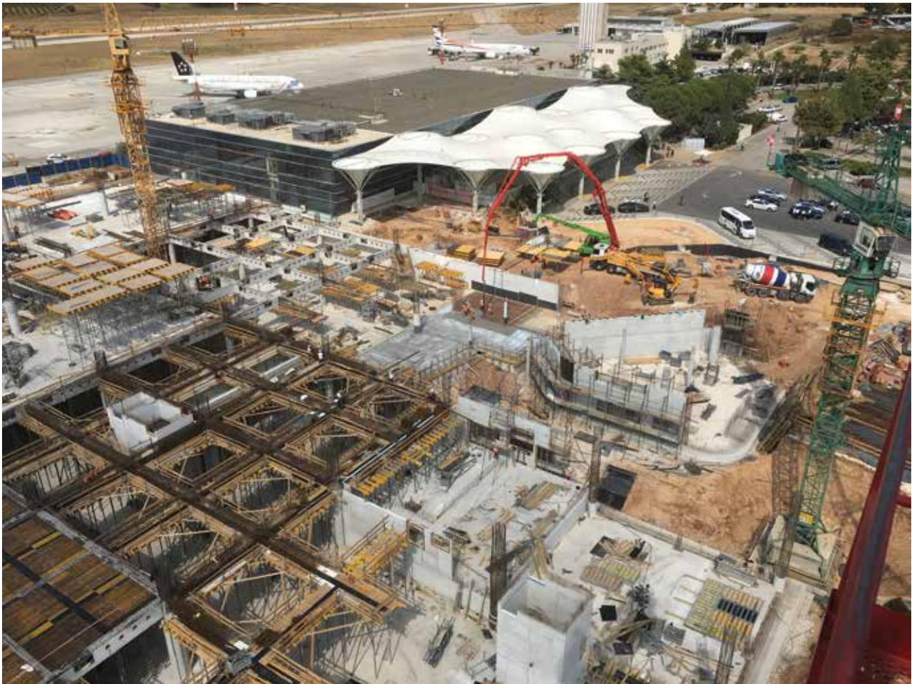
Detalj s gradilišta
