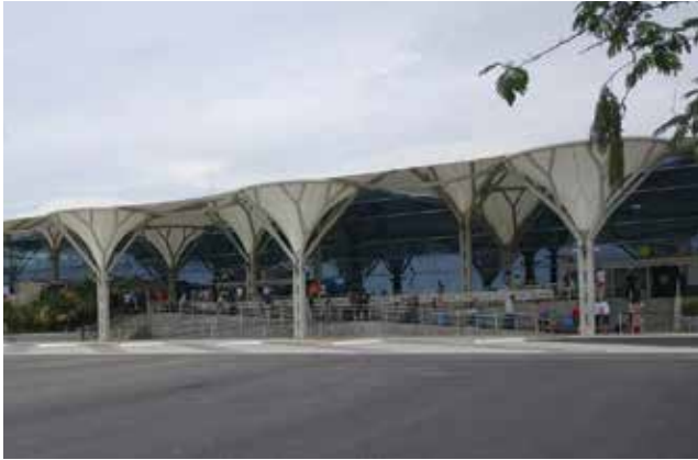
Pogled na putničku zgradu nakon rekonstrukcije 2004. godine
