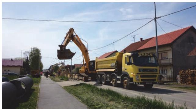
Gradnja kolektora Odranski most
