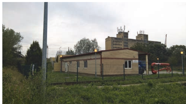
Gradnja CRK-a Kolodvor
