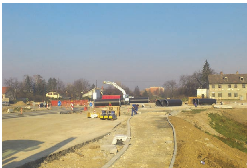
Gradnja kolektora Zeleni brijeg
