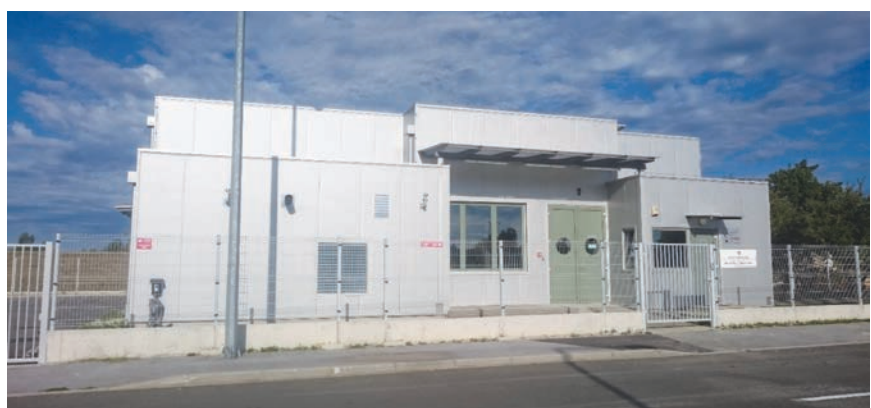
Rekonstrukcija CRK-a Odranski most
