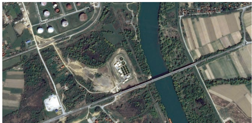
Gradnja UPOV-a kanalizacijskog sustava u Sisku
