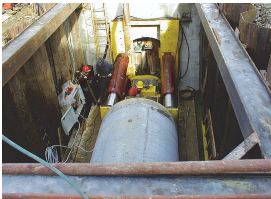
Gradnja rasteretnog kolektora CRK-a Kolodvor (mikrotuneliranje)
