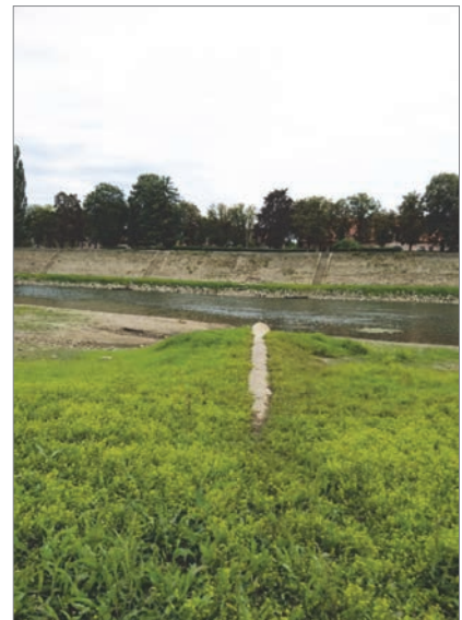
Postojeći kanalizacijski ispust u rijeku Kupu
