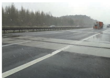
Slika 13. Primjeri poprečnih kanalicama izvedenih na autocesti u Njemačkoj
