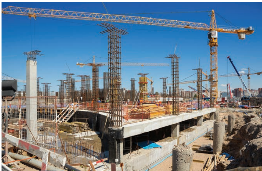
Detalj s gradilišta
