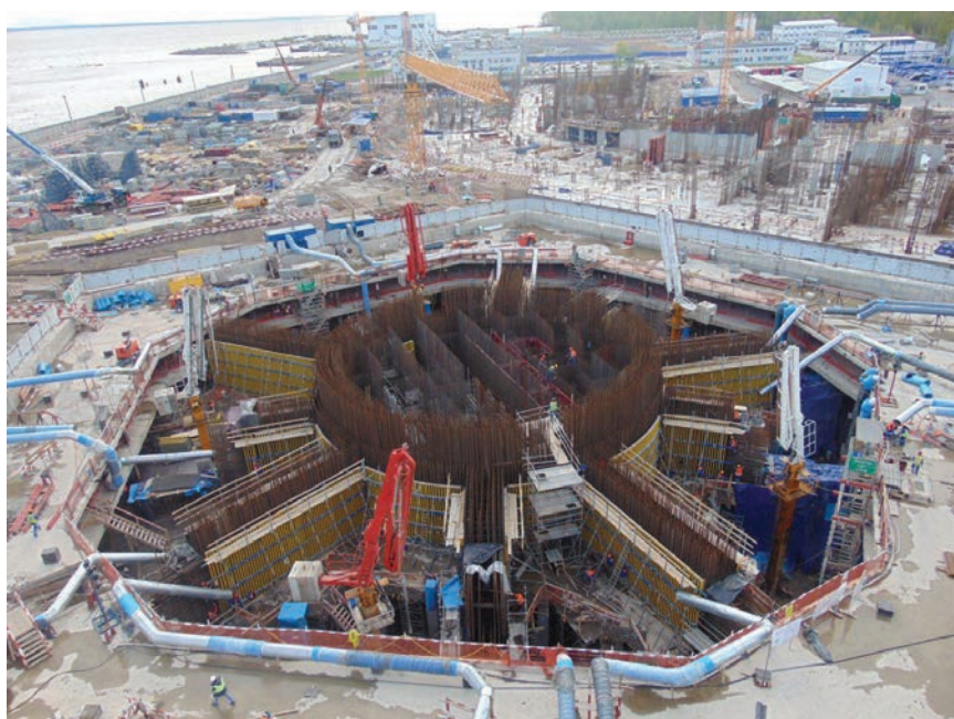
Prva faza betoniranja temelja
