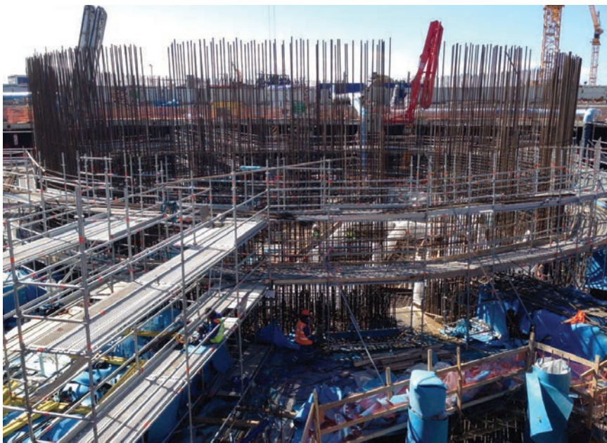
Armatura jezgre prije betoniranja
