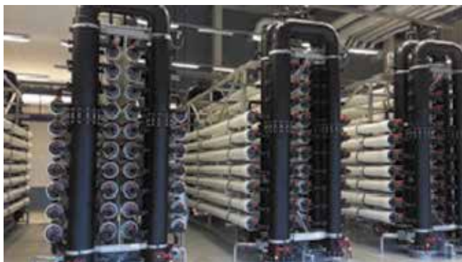
Slika 5. Horizontalno i vertikalno raspoređivanje modula za nanofiltraciju, [15, 16]
