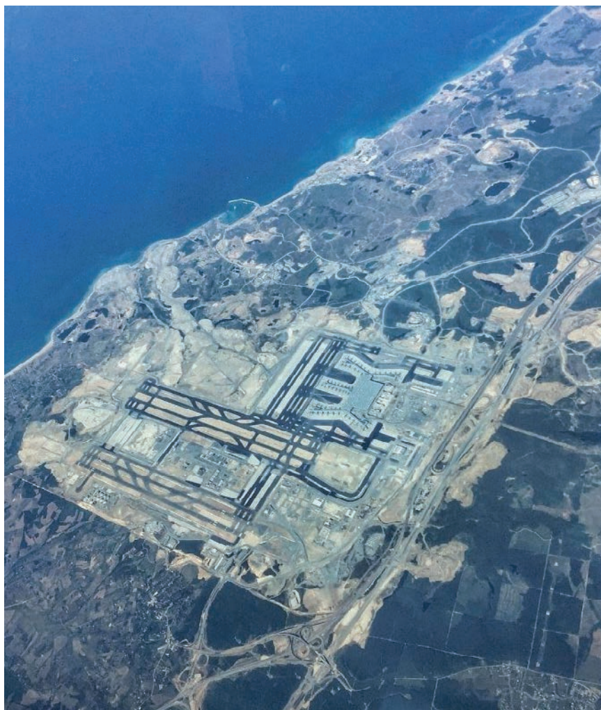
Gradilište snimljeno iz zraka (FOTO: Graham Bolton/Mott MacDonald)
