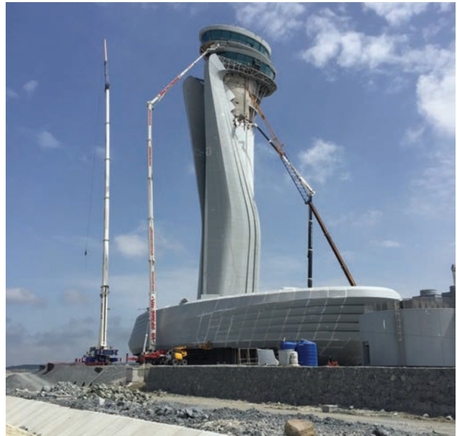
Detalj s gradilišta kontrolnog tornja
