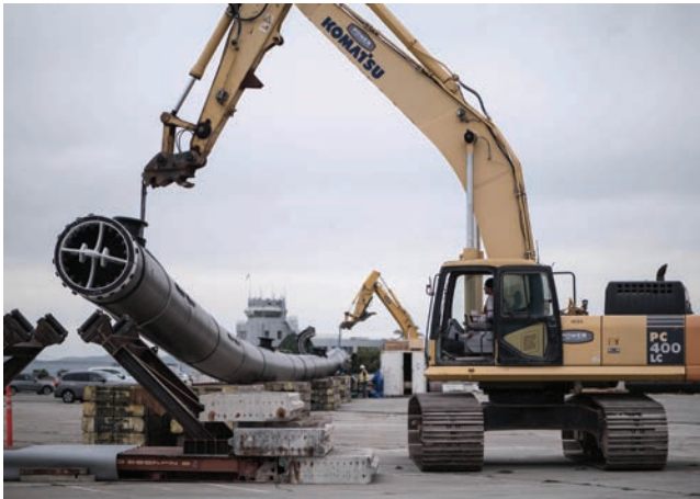
Detalj s gradilišta
