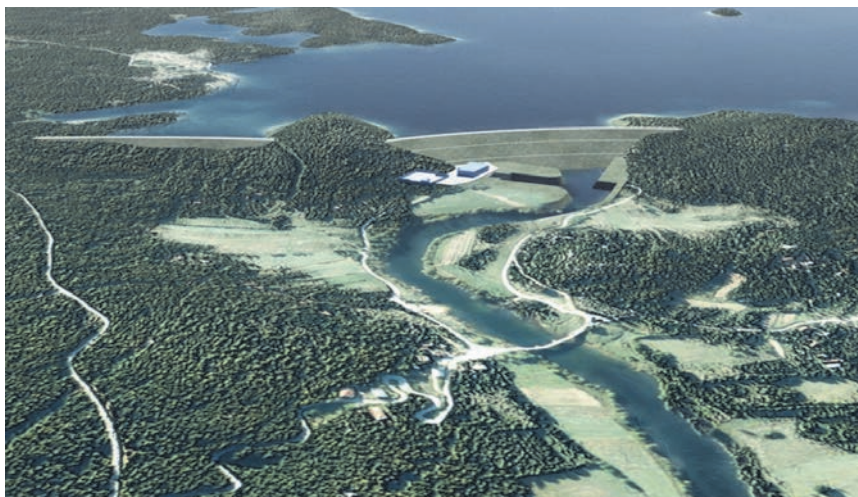
Pogled na donji dio akumulacije Kosinj, branu Kosinj, HE Kosinj i branu Sedlo – planirano stanje za koju je izrađena studija utjecaja na okoliš
