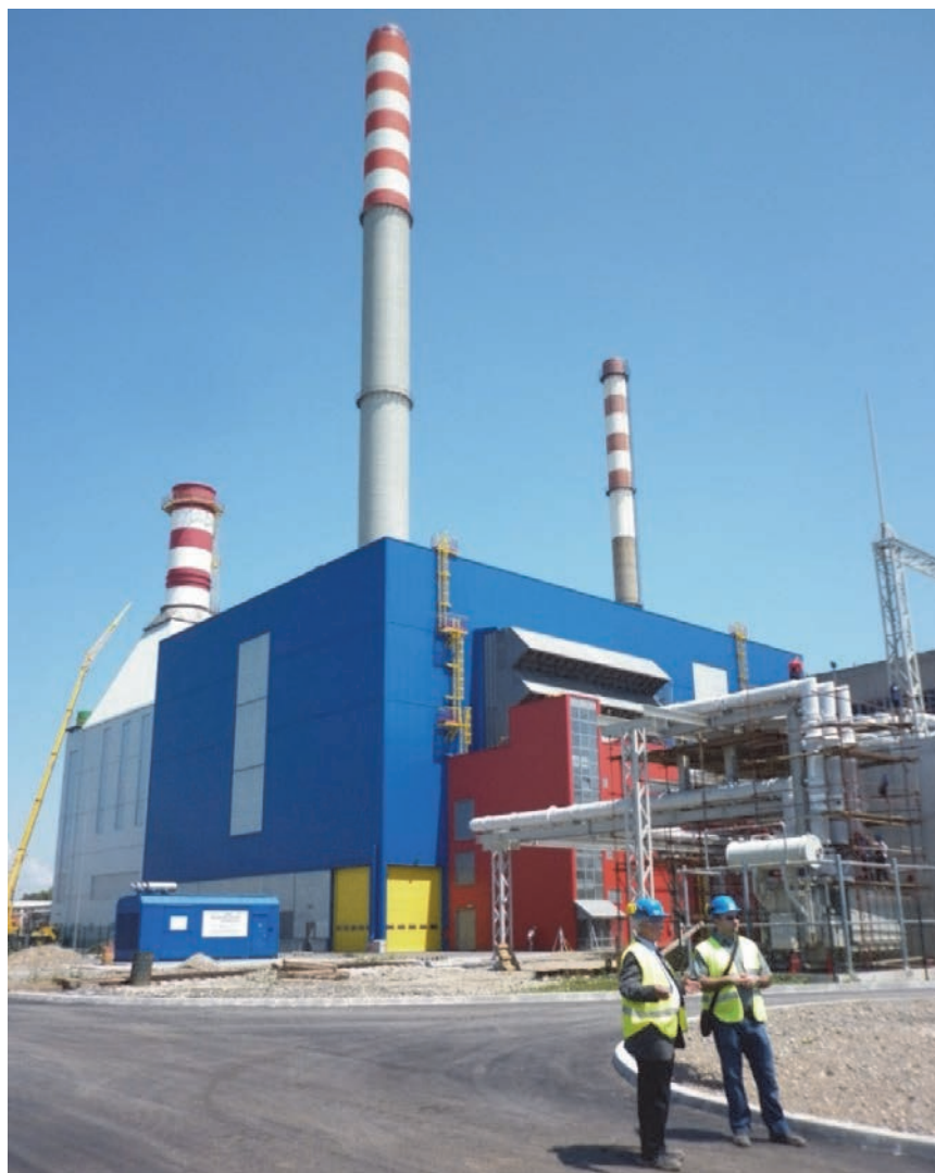
Blok C u Termoelektrani-toplani Sisak (kombi-kogeneracijska elektrana 250 MWe/50 MWt)
