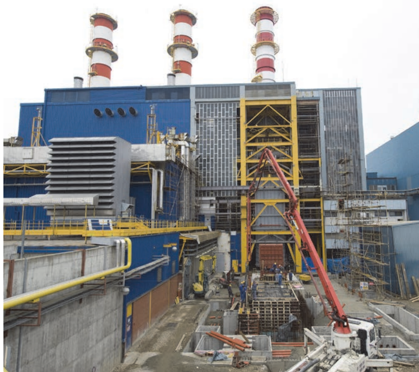
Blok L u Termoelektrani-toplani Zagreb (Izgradnja u uvjetima brownfield investicije – po dovršetku montaže trećega kotla s dimnjakom pristupilo se izradi temelja plinsko-turbinskog agregata)
