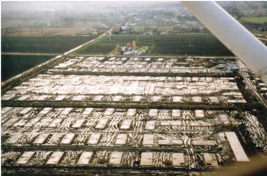
Poplava na gradilištu naselja Rokovci
